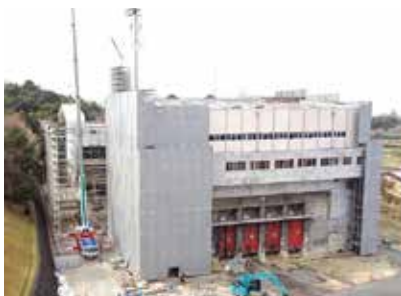
▲解体中の旧折居清掃工場
