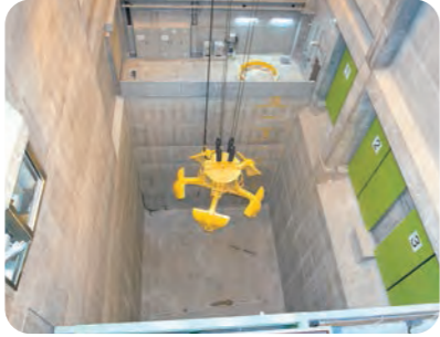
貯留ピットから、クレーンで受入ホッパに運びます。
