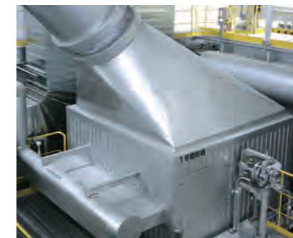
節炭機（エコマイザ） 排ガスは高温のため、冷却して温度を調節し、ダイオキシン類の発生を抑制します。またボイラに給水する水温を高くし、ボイラ効率を高めます。
