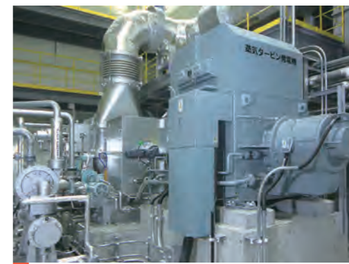
蒸気タービン発電機 ボイラで発生した蒸気で発電しています。最大2,110kWの発電を行う能力を持っています。
