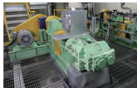
飛灰処理設備 ろ過式集じん器で回収された飛灰を薬剤処理し、重金属の溶出を防止します。
