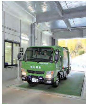
ごみ計量機 ごみ収集車で運ばれてきたごみの重さを測ります。
