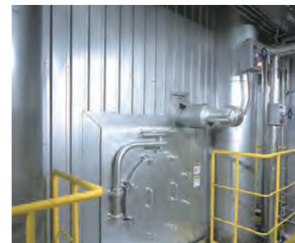
無触媒脱硝設備 焼却炉にアンモニアガスを噴霧し、安定的に窒素酸化物を除去します。
