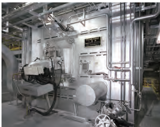
焼却炉 燃焼温度850℃以上、ガス滞留時間2秒以上を確保し、ダイオキシン類の発生を抑制します。
