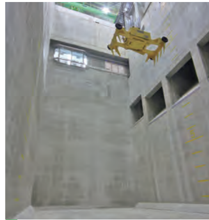
ごみピット・ごみクレーン ごみピットに貯留したごみはごみクレーンで攪拌してから、焼却炉に投入します。ごみピットには5.2日分のごみを貯留することができます。
