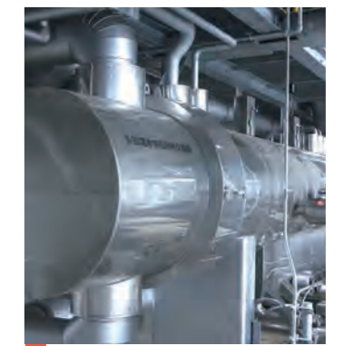
外部温水供給装置 隣接する山城総合運動公園に温水を供給します。
