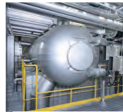
ボイラ ごみの焼却により発生する熱を利用し、高温・高圧の蒸気を発生させます。
