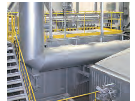
ろ過式集じん器 排ガス中の有害物質（ばいじん・ダイオキシン類・塩化水素・硫酸酸化物・水銀）を除去します。
