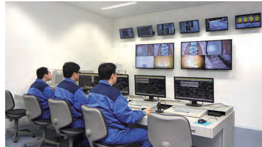
この施設の頭脳といえるところです。施設全体を24時間監視・制御しています。
