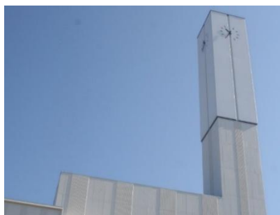
▲煙突外壁部分に膜構造を採用した 世界初の「次世代煙突」
