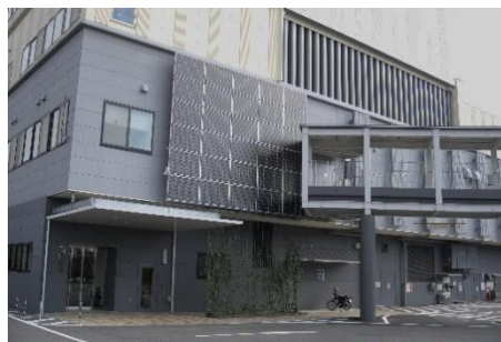
▲壁面緑化と太陽光パネル
