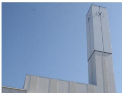
▲煙突外壁部分に膜構造を採用した
