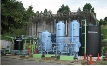
処理方式 標準脱窒素処理方式+砂ろ過方式+活性炭
