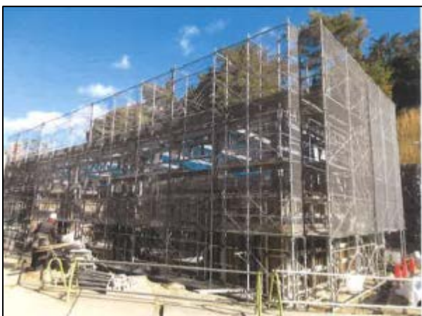
ストックヤード棟
