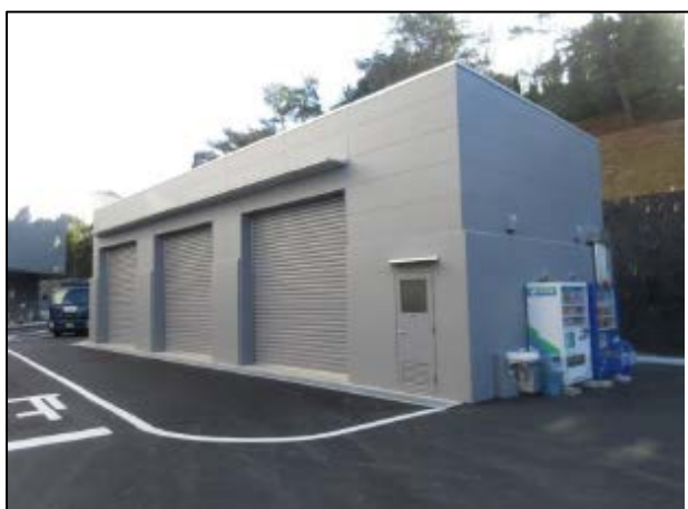
ストックヤード棟
