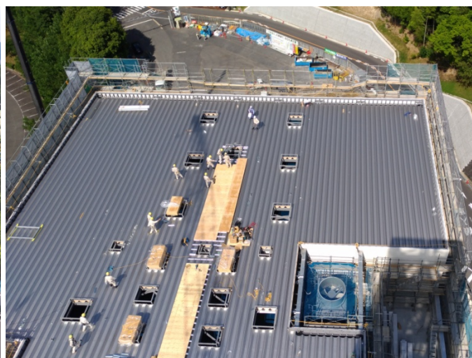
煙突上から見た工事現場
