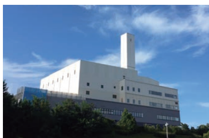
▲太陽が丘から見た建設中の工場
