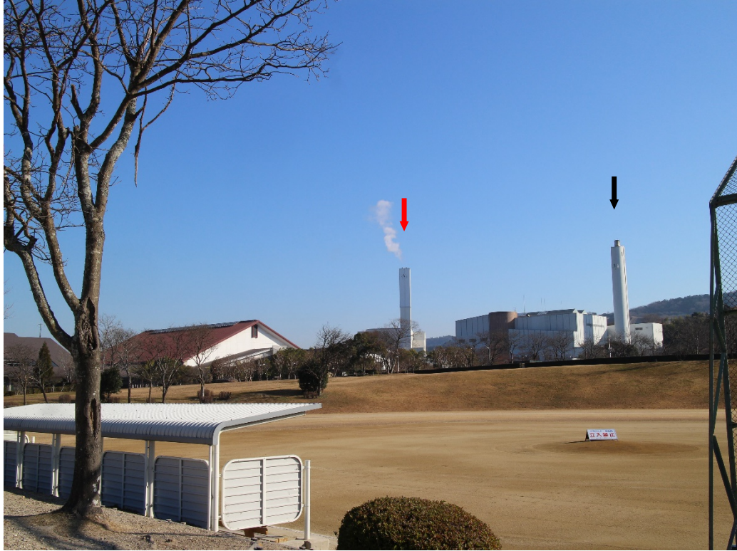
↓は更新施設の煙突を示す。↓は、旧施設の煙突を示す。
